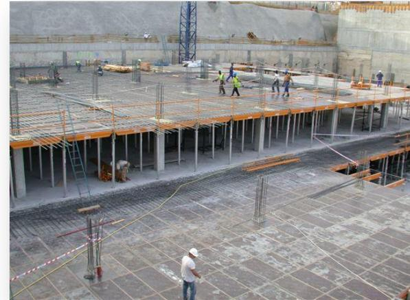
tablero COMPOSITE para encofrado
