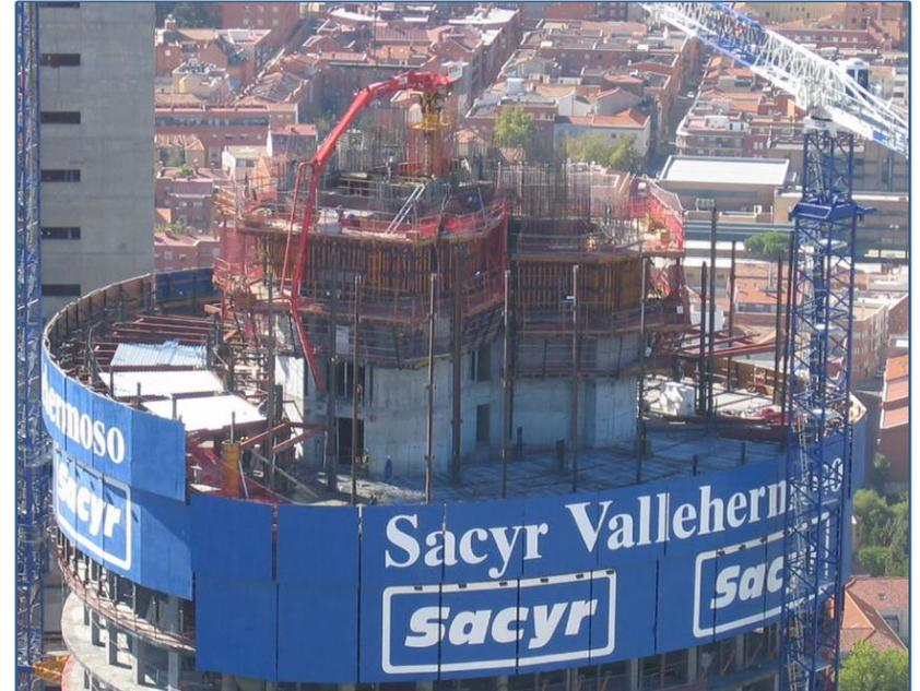
Distribuidor de hormigón incorporado en plataforma
