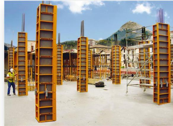
Al tablero COMPOSITE para encofrado
