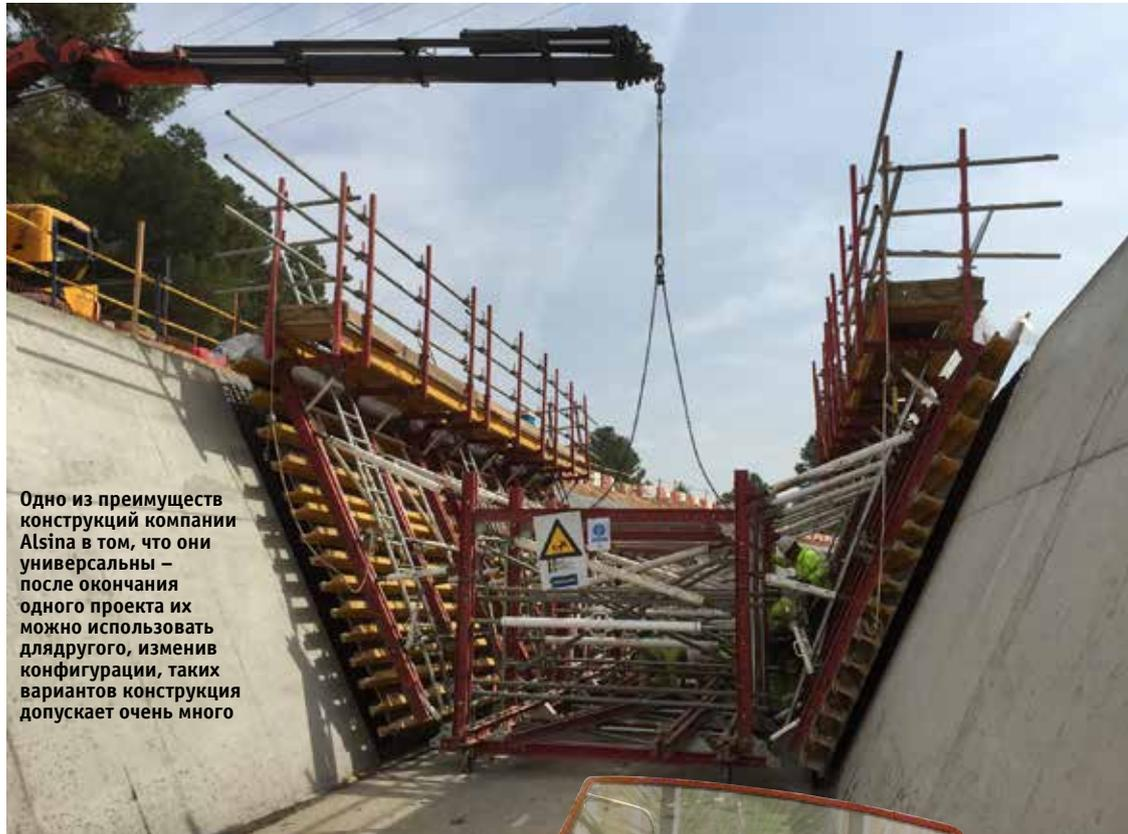
Одно из преимуществ конструкций компании **Alsina** в том, что они универсальны – после окончания одного проекта их можно использовать для другого, изменив конфигурации, таких вариантов конструкция допускает очень много
