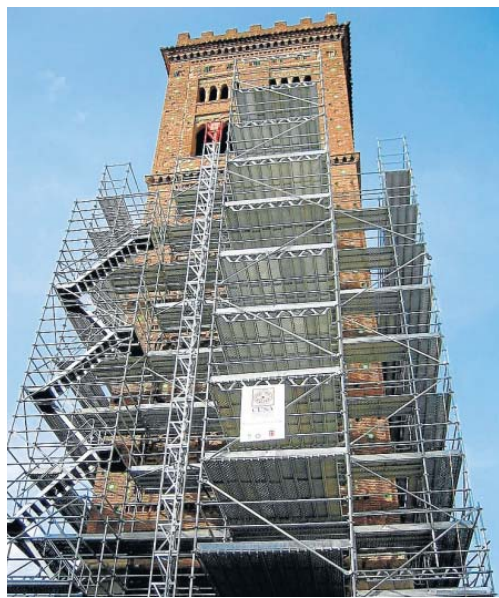
Andamios de Tendo, en una de las torres mudéjares en Teruel. TENDO
